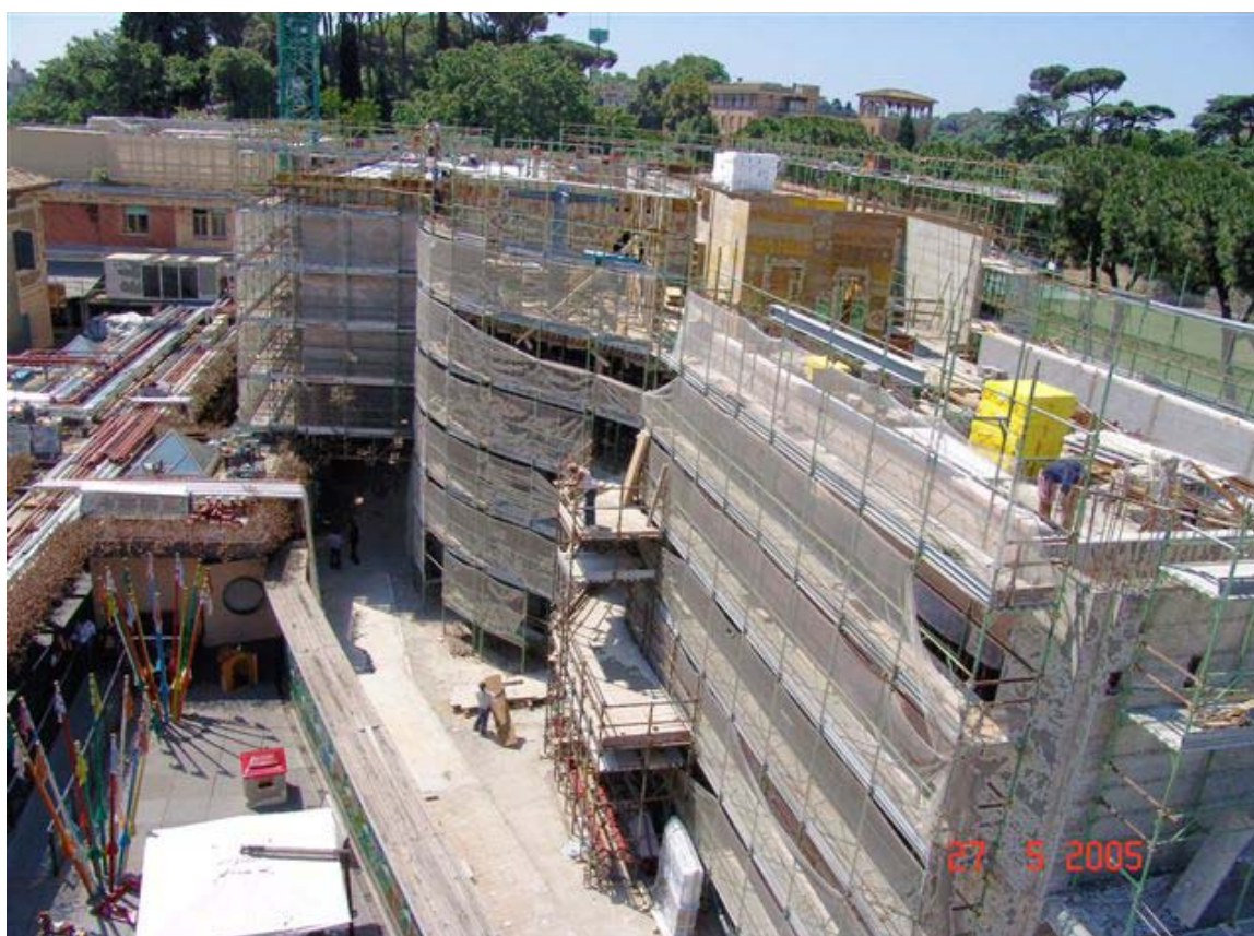
Fasi della costruzione del nuovo padiglione dell'Ospedale Pediatrico Bambino Gesù
